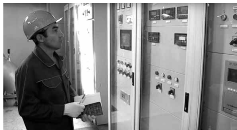
В Южном Казахстане действуют четыре солнечных электростанции. Еще шесть будут построены до конца 2025 года. Фото автора
