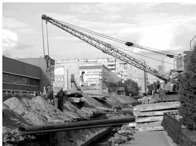
Замена магистральных и внутриквартальных тепловых сетей обеспечит тысячи потребителей горячей водой, которую они не видели уже почти два года. Фото автора
