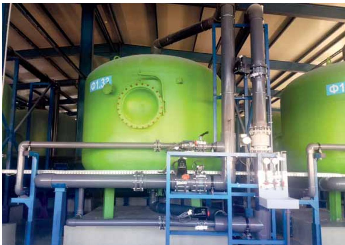
Завод «Каспий» – единственное в Казахстане предприятие, использующее технологию обратного осмоса для очистки морской воды. Фото автора
