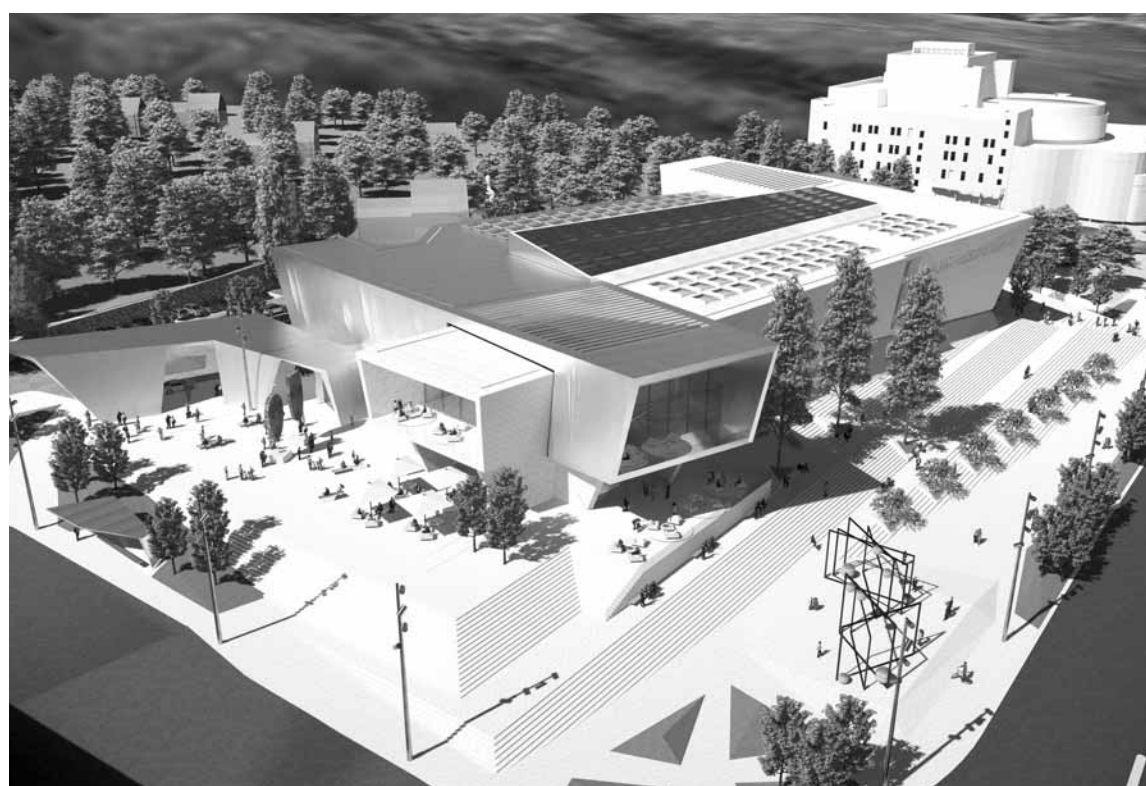
Северный и восточный фасад. Вид сверху.
