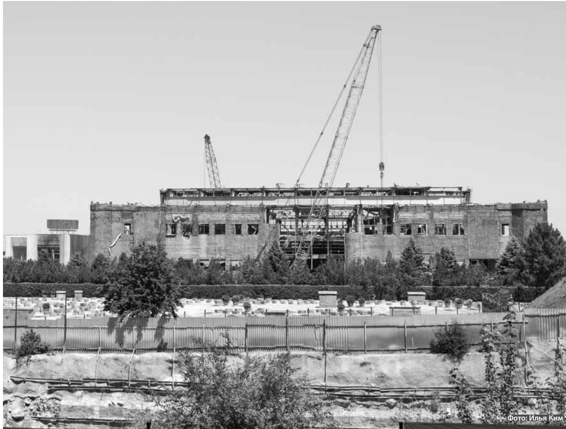
Демонтаж резиденции президента. Алматы, 8 июня 2022 г.
