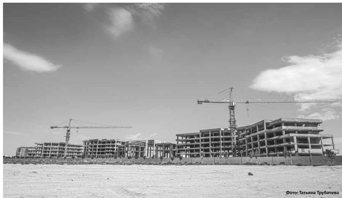
Строительство отеля Fairmont в Актау остановлено.
