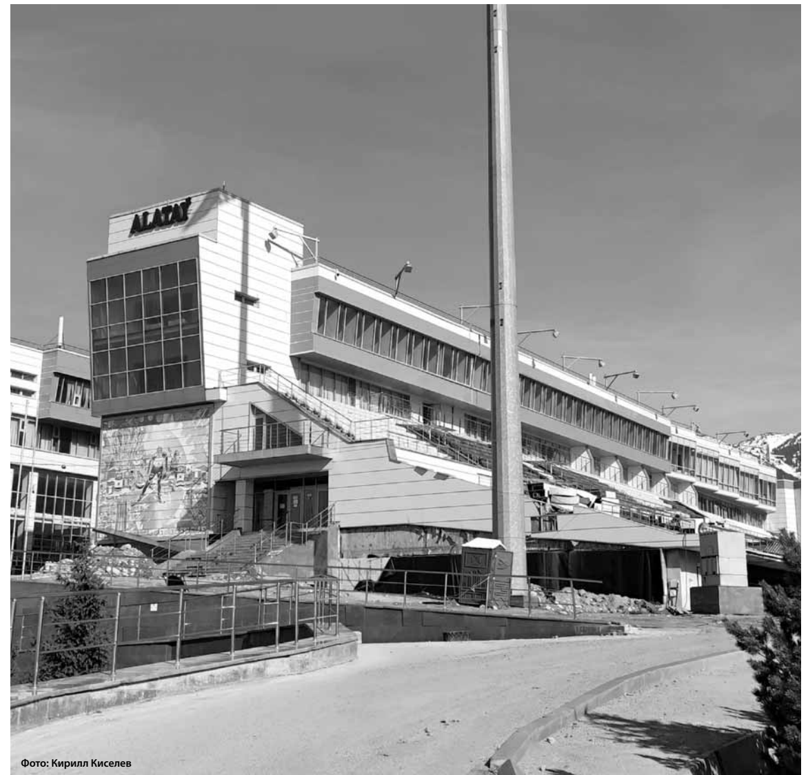
Капитальный ремонт зданий и сооружений лыжно-биатлонного комплекса «Алатау».
